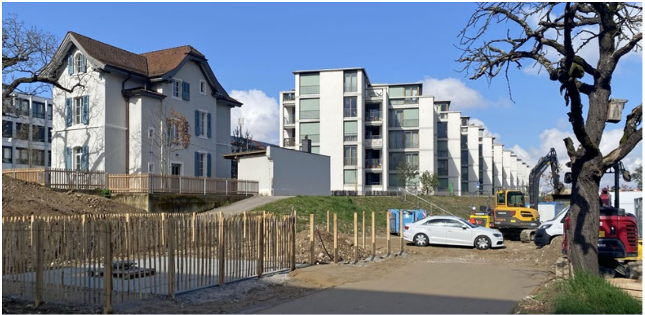
Die Arbeiten der Stadtgärtnerei am Quartierkompost unterhalb der Burgfelderstrasse haben begonnen. Foto: G. Köhler
