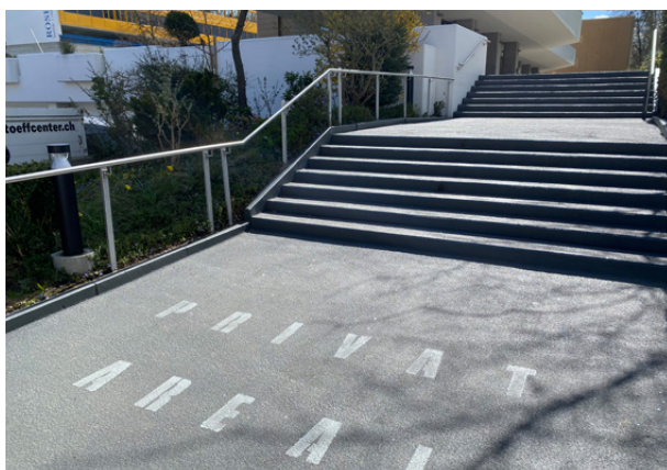
Die sanierte Treppe, neu mit Antirutschbelag und Beschriftung.
