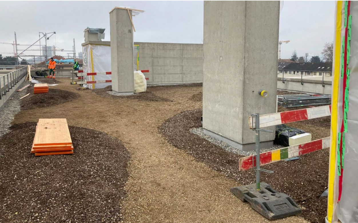
Die fortgeschrittenen Dachsanierungsarbeiten, Foto: Wenger AG Gartenbau
