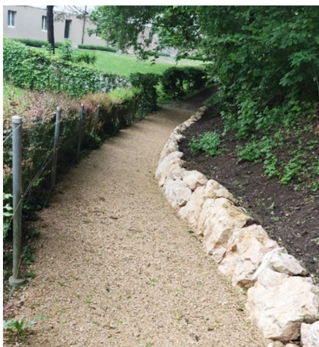
Der Waldweg im Waldhof nach der gelungenen Sanierung.
