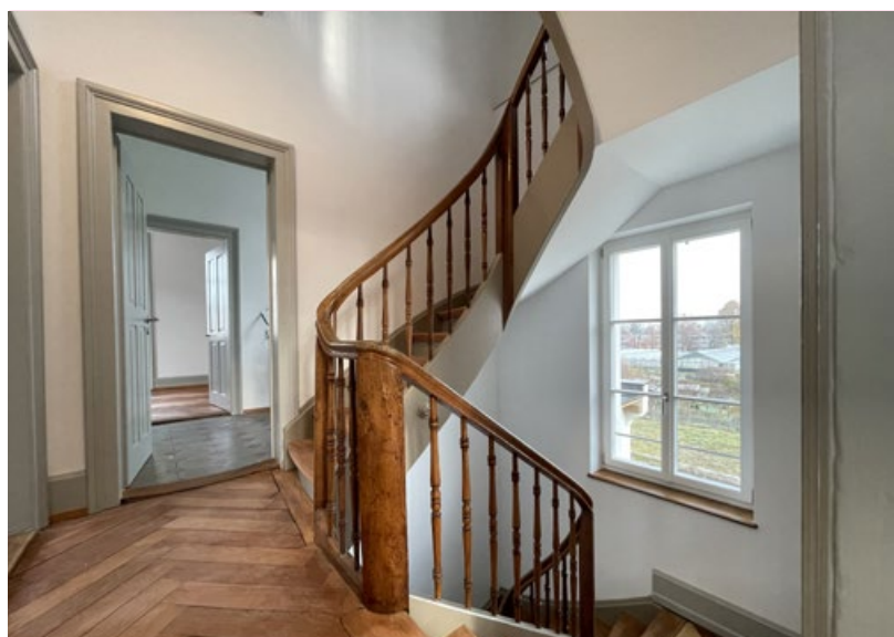
Das Treppenhaus im alten Zollhaus wurde sorgfältig renoviert.
