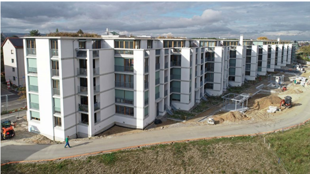
Stand der Arbeiten Ende Oktober 2021 auf der Rückseite der Burgfelderstrasse. Foto: www.mazy.ch
