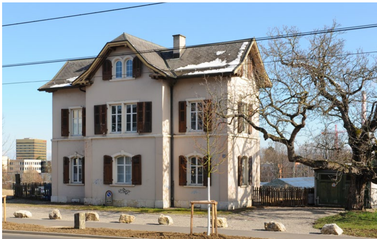
Das alte Zollhaus, welches im 2022 umgebaut werden soll, von der Strasse aus gesehen.
