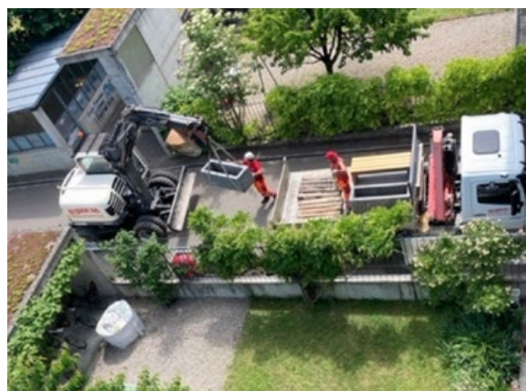
Arbeiten an der Begegnungszone Frühling 2021
