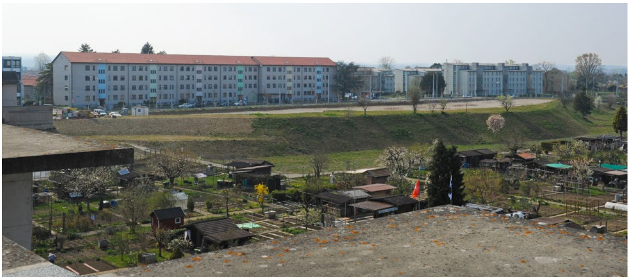
Es kann losgehen: Blick aufs Baufeld vom Dach der Bungestrasse 20 aus gesehen.
