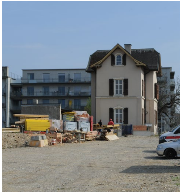
Das Zollhaus vom Baufeld aus gesehen.
