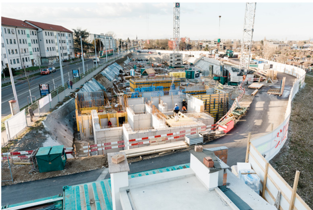
Blick auf die Baustelle Burgfelderstrasse Ende 2019. Foto © B. Haberthür, zVg. NORD Architekten
