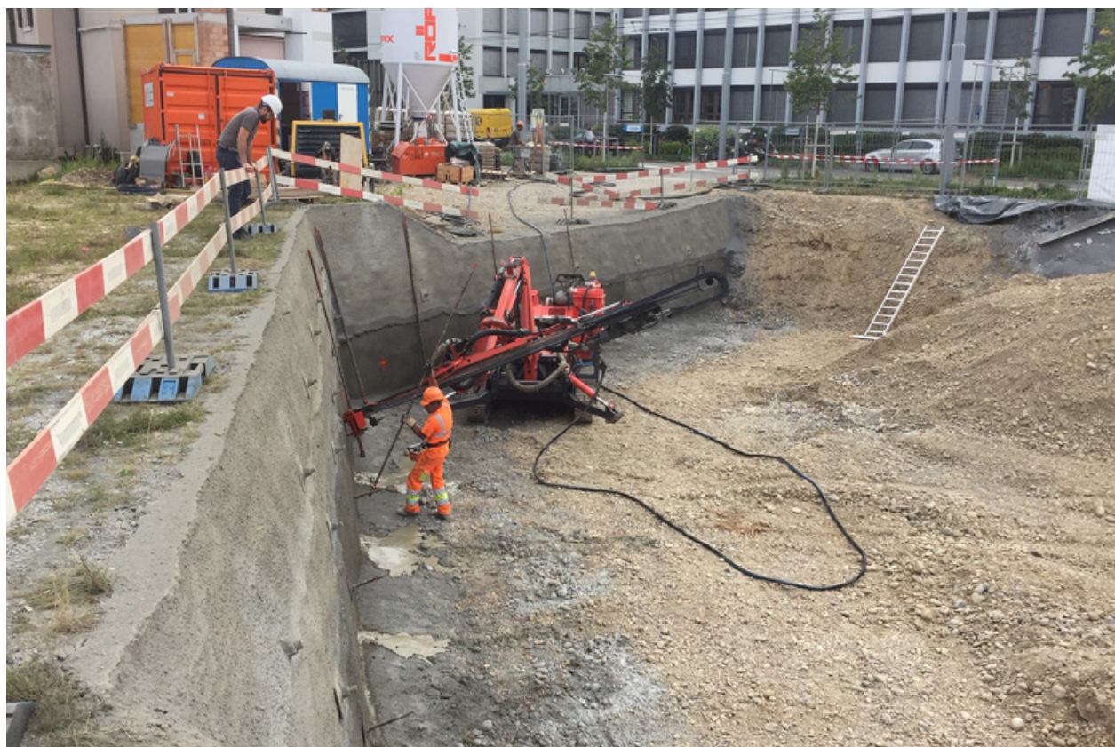
Burgfelderstrasse: Arbeiten Anfang September in der riesigen Baugrube. Foto: © B. Haberthür
