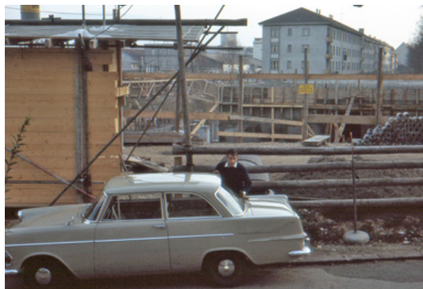
Blick auf die Baustelle (undatiert), Fotos zVg.
